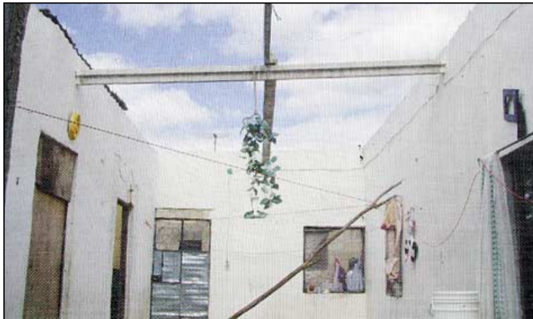
OTRA DE las viviendas dañadas por el huracán Isidore en Conkal y que perdió todo el techo.
